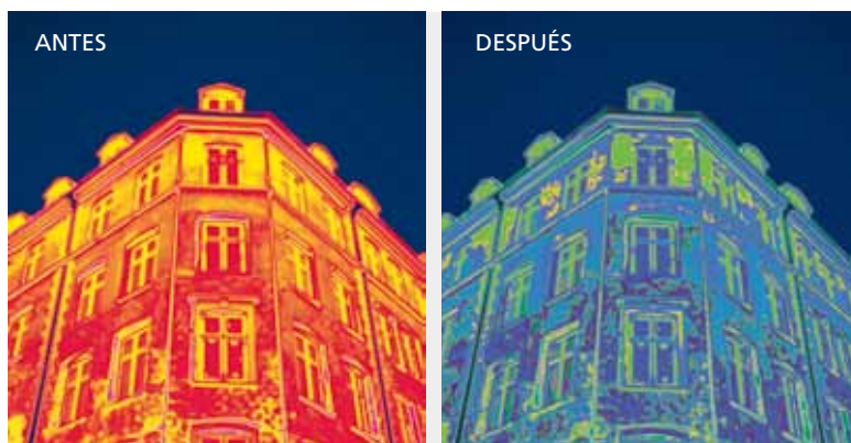
Vista a través de termografías de la superficie de un edificio antes y después de aplicar revestimiento aislante.
